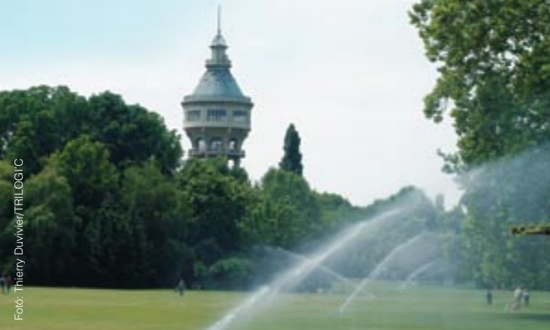
Az 1911-ben épült margitszigeti víztorny
