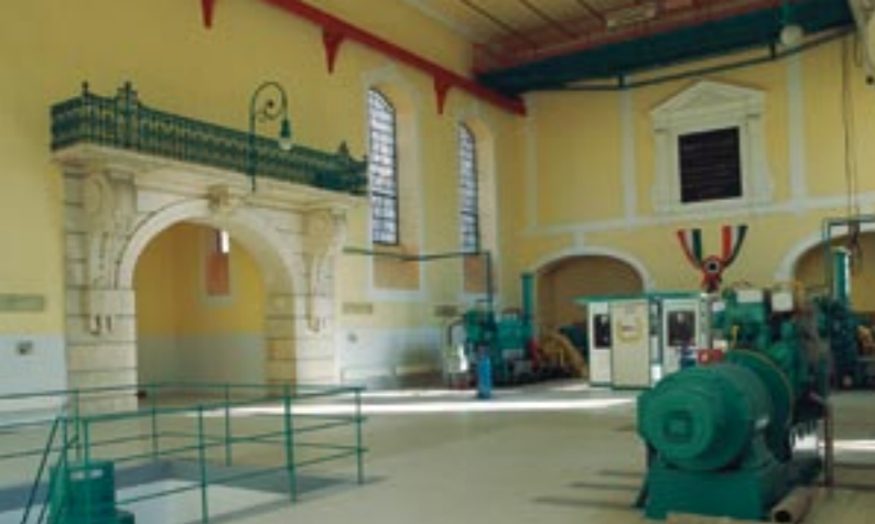
Az 1893 és 1904 között épült kaposztásmezei fűtőtelep gépháza
