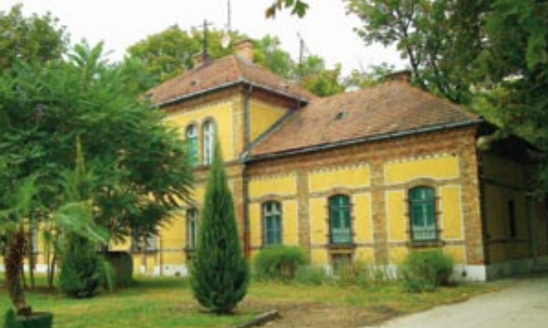
Az 1902-ben épült balparti I-es átemelő gépház
